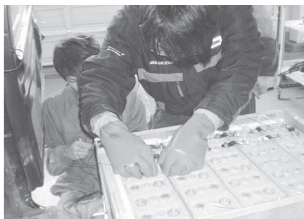
Fig.7 バッテリー接続の様子
