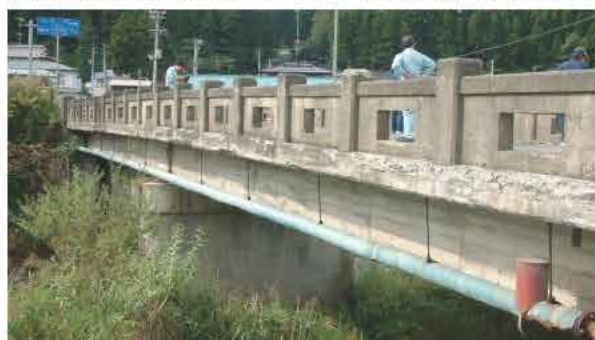
既存橋梁の耐久性調査
