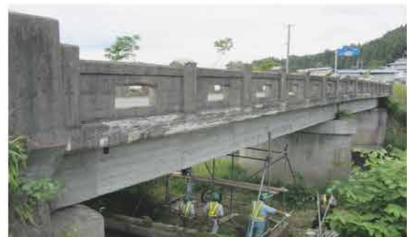
老朽化した橋梁の調査
